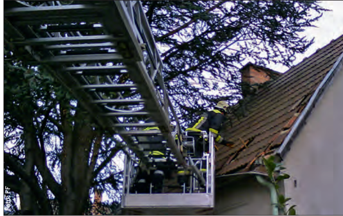
Heftige Sturmböen: Lose Dachziegel mussten eingehängt werden
