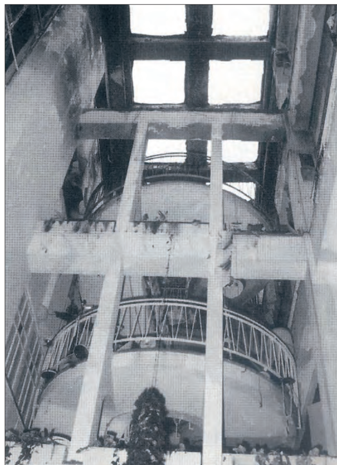
Die offene Kundenstiege vom dritten in den vierten Stock (links) und das vom Keller bis in das Obergeschoß vollkommene offene Stiegenhaus zeigen deutlich, dass es keinen Brandabschnitt gab.
