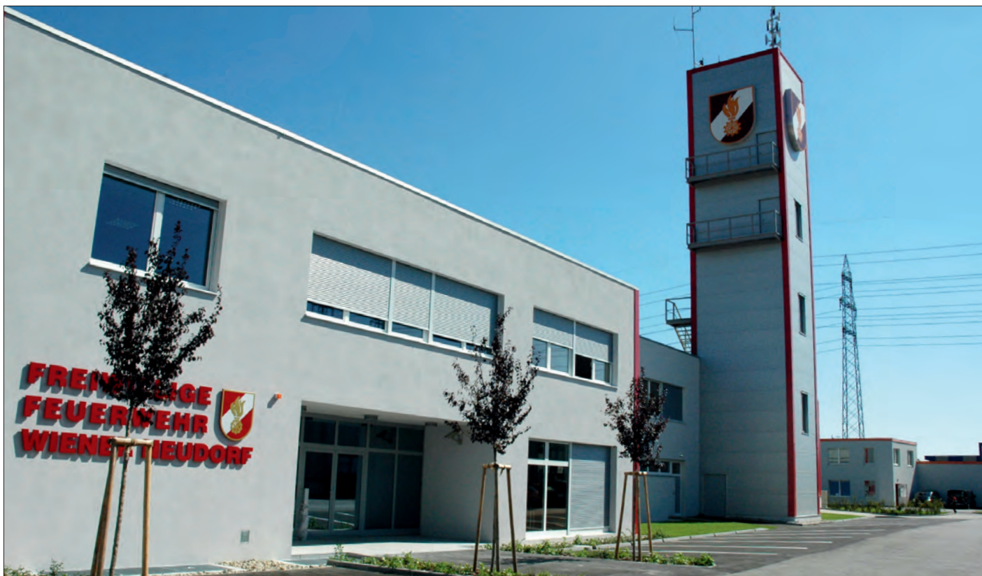
Zwischen Industriezone und Ortskern gelegen: Das neue Feuerwehrhaus in Wr. Neudorf
