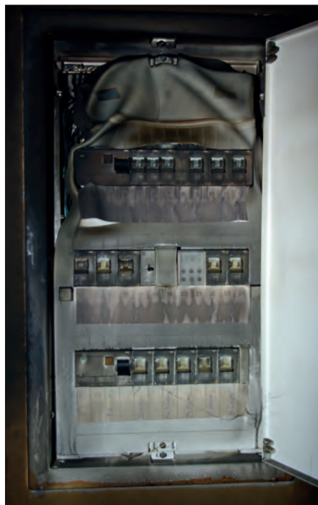
Die Sicherungsstellung von Schaltzuständen vor dem Stromlosschalten ist für die Ermittlungen nicht unerheblich.
