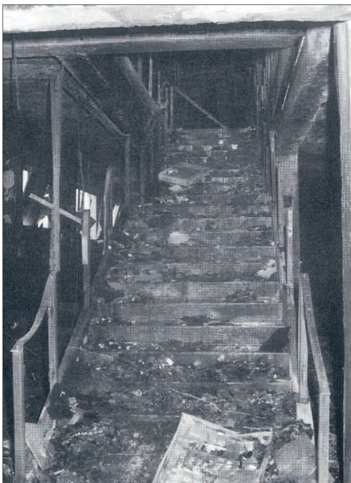
Die offene Kundenstiege vom dritten in den vierten Stock (links) und das vom Keller bis in das Obergeschoß vollkommene offene Stiegenhaus zeigen deutlich, dass es keinen Brandabschnitt gab.
