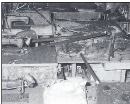
Die Schneiderei im 5. Obergeschoß
