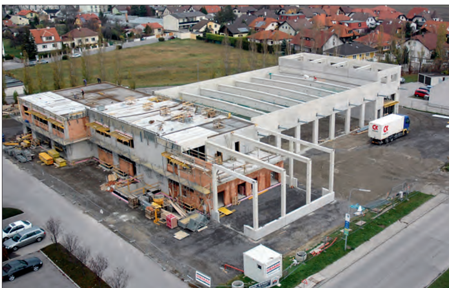
In nur 13 Monaten wurde ein gut geplantes Feuerwehrhaus gebaut
