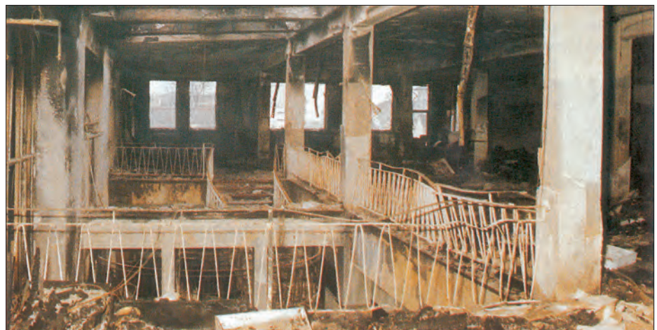
Komplett zerstörter Innenraum des Gebäudes am Rathausplatz
