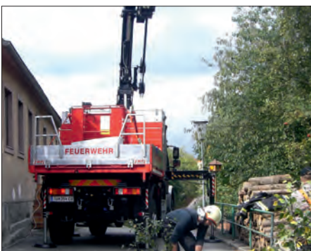
Feuertaufe nach Sturmschäden
