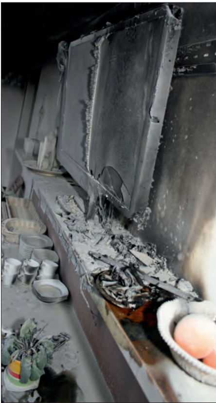
Kleine Ursache - großer Schaden durch einen Kleinbrand
