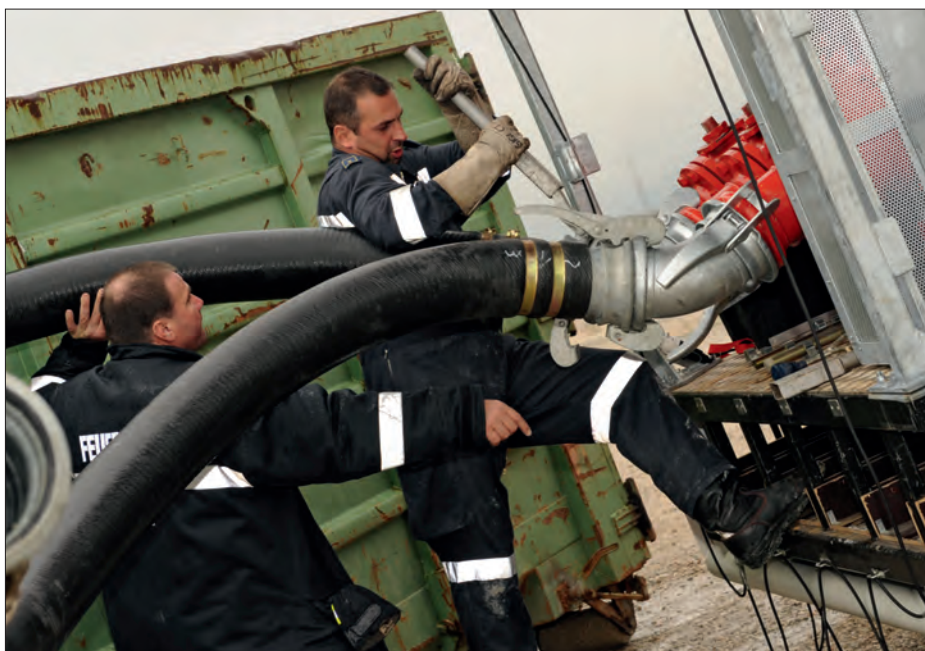
Voller Einsatz an der Sonderpumpanlage 900
