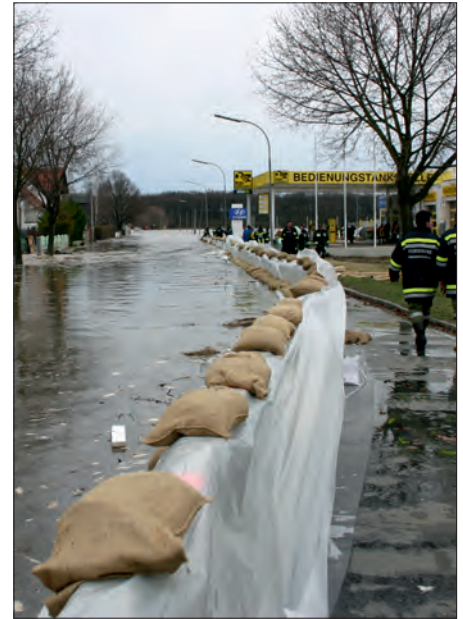
Von der Feuerwehr behelfsmäßig errichtete Dämme sollten das Schlimmste verhindern.
