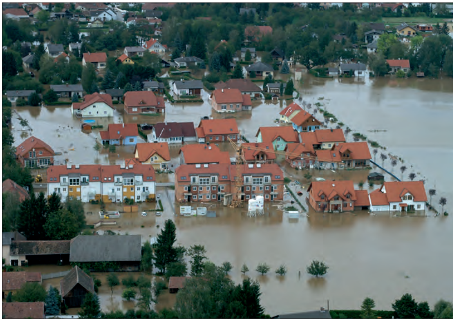
Die neue Siedlung in Grafenwörth 2002: Das Hochwasser fügt den Neubauten schwere Schäden zu.
