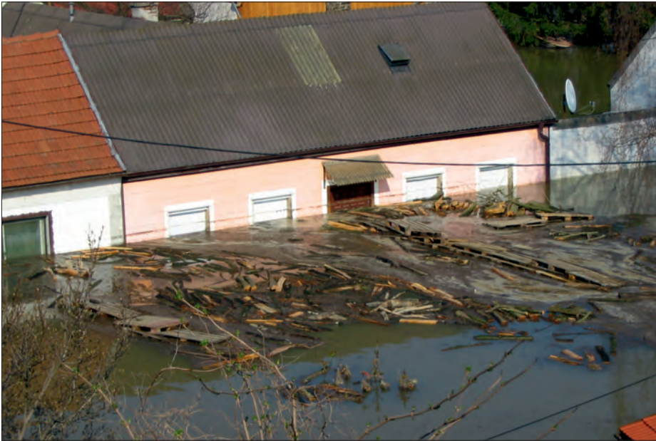
Vorbeugender Hochwasserschutz soll Katastrophen wie jene im Weinviertel künftig verhindern. Für den Besitzer dieses Hauses kommt vorbeugende Hilfe gegen Schäden allerdings zu spät.
