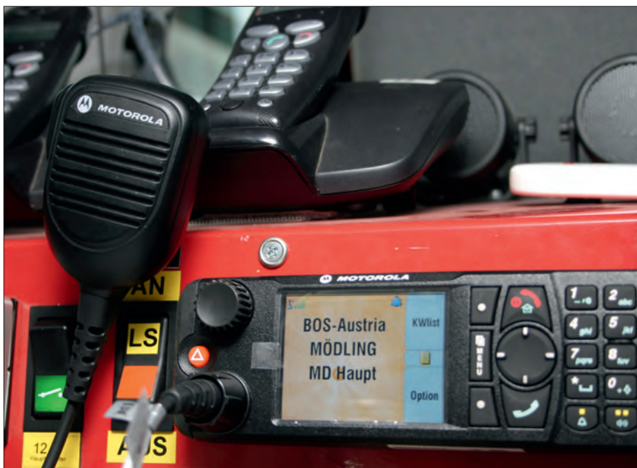
Kommunikation zwischen BAWZ und Einsatzleitung erfolgt größtenteils über TETRA
