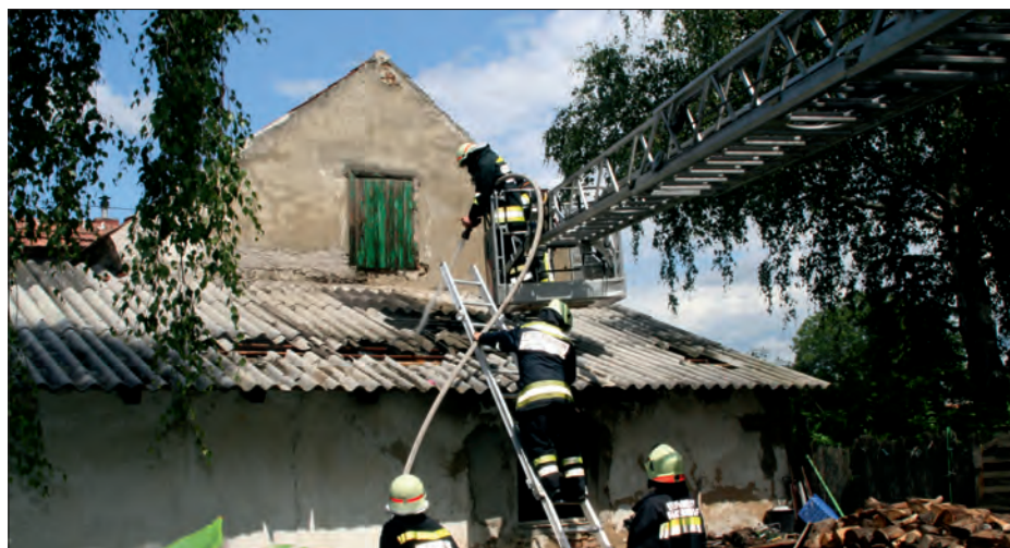
Nachlöscharbeiten und Öffnen der Dachhaut, um Glutnester abzulöschen
