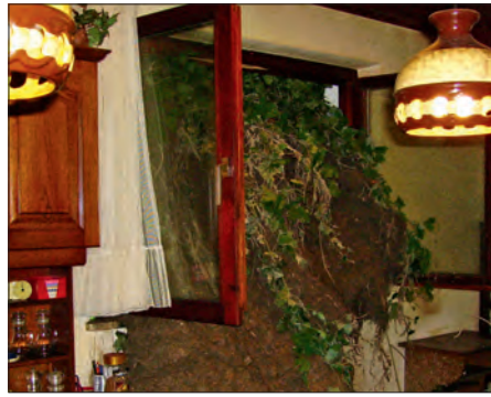
Aufgeweichtes Erdreich drang in Wohnhaus
