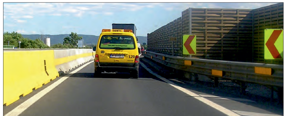
„Staufalle“. Kein Weiterkommen. Nachkommende Einsatzfahrzeuge stecken ebenfalls fest.
