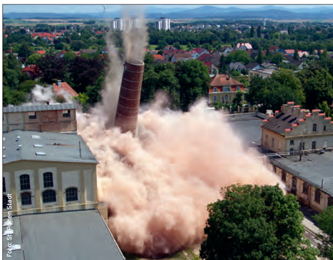
32 Kilogramm Sprengstoff: Spektakuläre Sprengung
