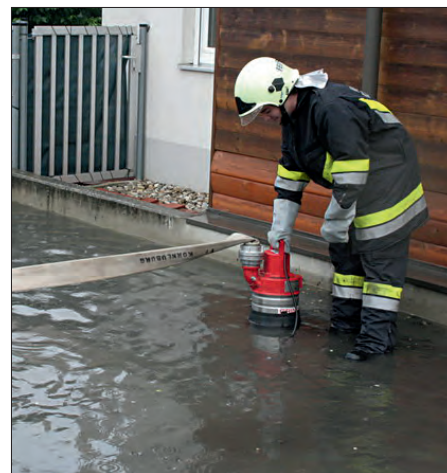
Auspumparbeiten in Korneuburg
