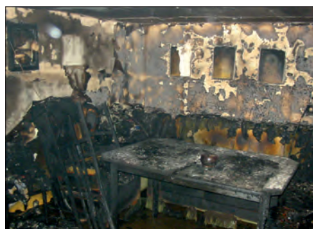
Das komplett ausgebrannte Wohnzimmer
