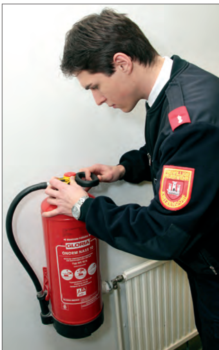
Kontrolle von Löscheinrichtungen vor der Veranstaltung
