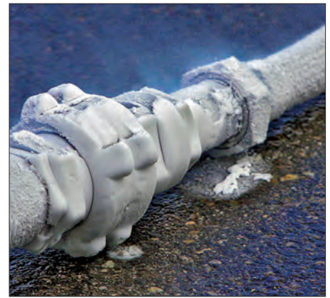
Der flüssige Stickstoff verursacht ein Vereisen der Metallleitungen und Kupplungen
