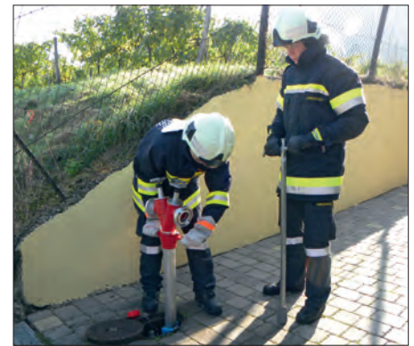
Ob Quelle Unterflurhydrant
