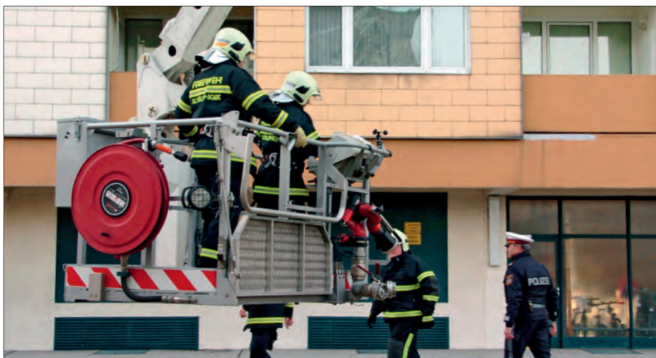
Teleskopbühne bei Brand im fünften Obergeschoss im Einsatz
