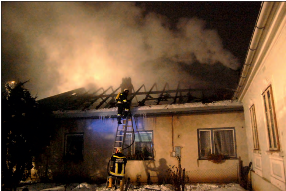
Nachlöscharbeiten unter Atemschutz mit Leiter
