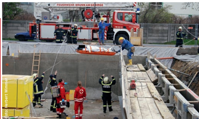
Ein Bauarbeiter war in Brunn am Gebirge, Bez. Mödling, in eine Baugrube gestürzt und konnte nur mit Hilfe der Freiwilligen Feuerwehr gerettet werden.
