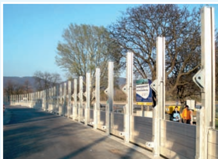
Phase 1 Verschluss der Sockelmaueröffnungen
