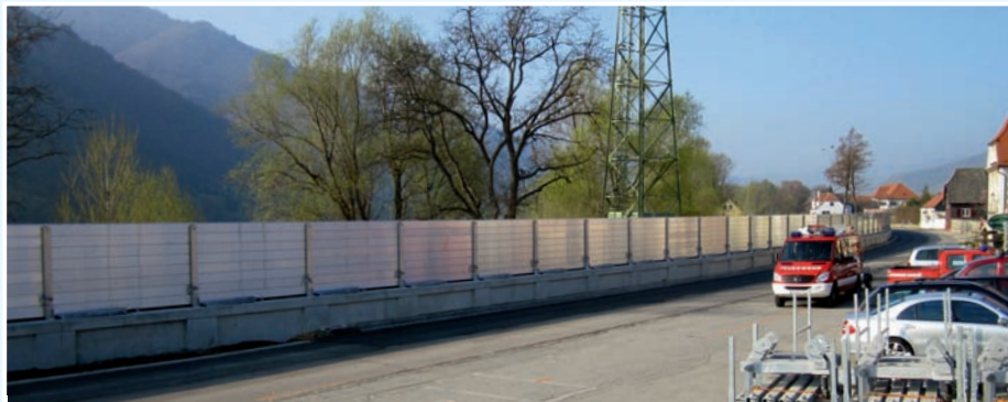
Die fertig aufgebaute Wand
