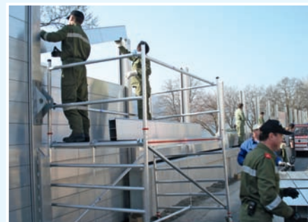
Einlegen der Dammbalken
