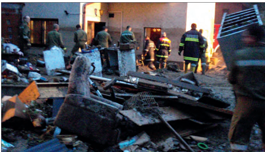
Die FF Thal war mehrere Tage damit beschäftigt, Häuser und Straßen vom meterhohen Schlamm zu befreien
