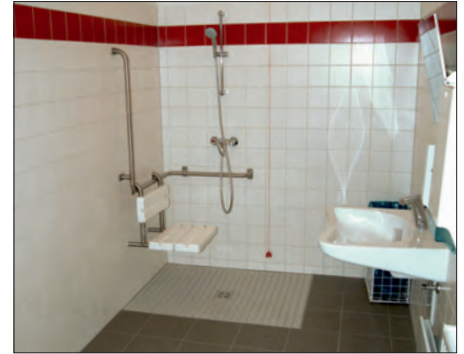
Innen: Moderne Sanitäreinrichtungen, ...
