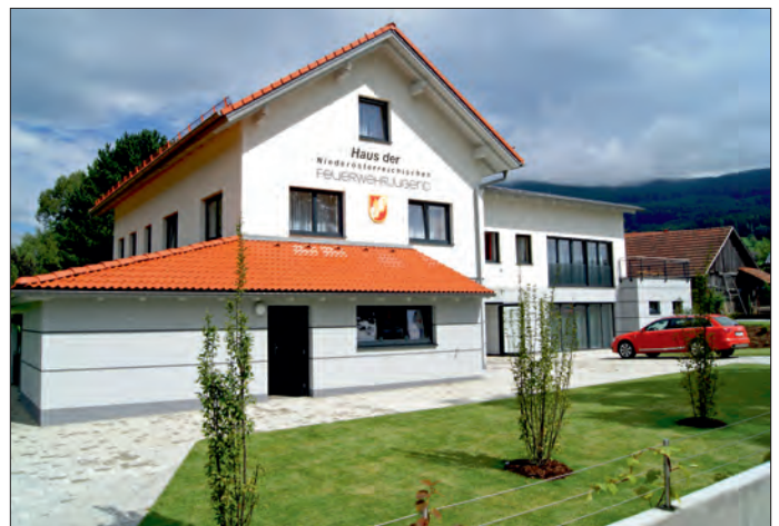
Das neue Haus der NÖ Feuerwehrjugend
