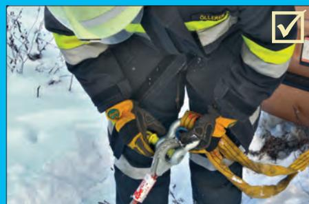
Richtig: ausreichend dimensionierte Schäkel immer als Verbindungselement zwischen Ketten, Rundschlingen, Hebebändern, etc. verwenden.
