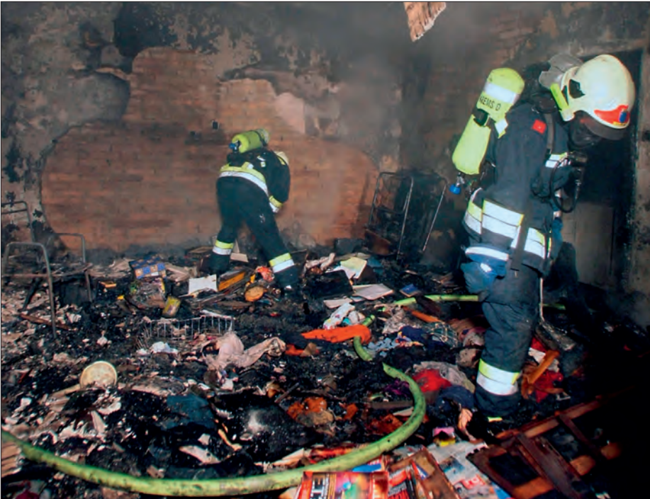
Die Wohnung in der Kremser Altstadt wurde durch das Feuer völlig zerstört
