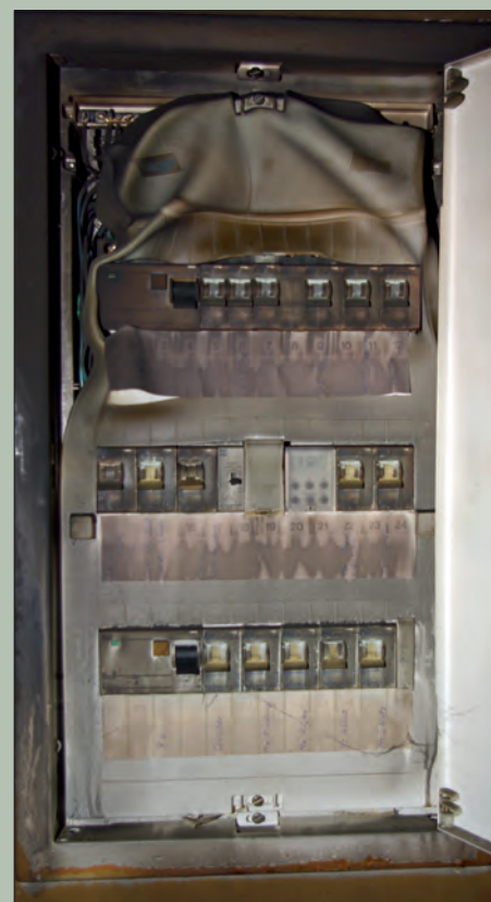
Abb. 3: Nicht immer ist – wie bei diesem Bild durch die Rauchgasablagerungen gekennzeichnet – das Ansprechverhalten von Sicherungen auch nach dem Brand noch erkennbar
