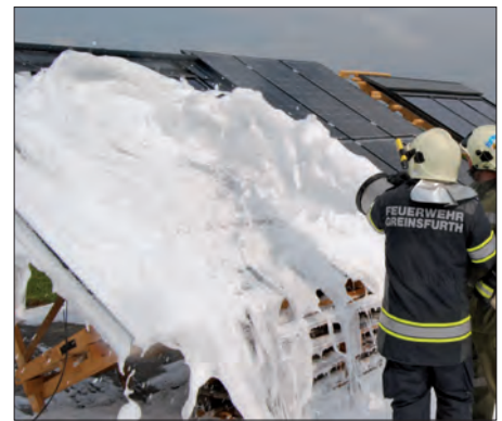
Abdecken der Photovoltaikanlage mit Löschschaum erzielt nur wenig Wirkung
