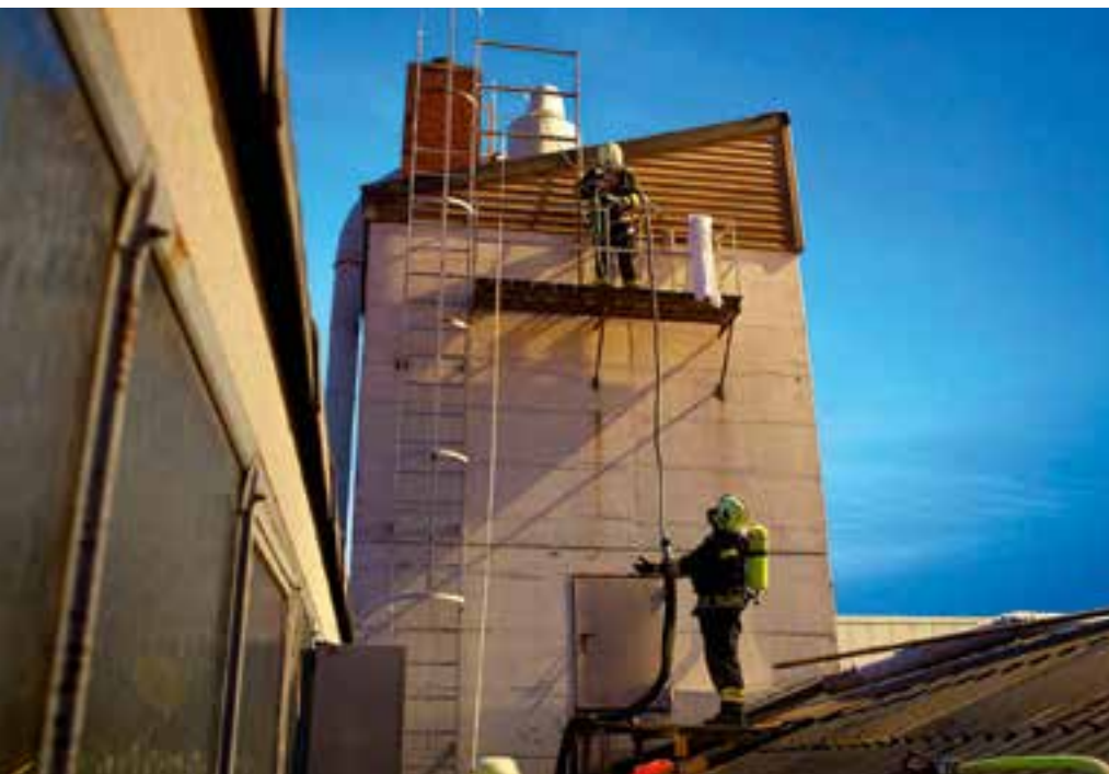
Bildtext oben: Aufstieg auf den Silo, Höhenangst wäre in dieser Situation äußerst gefährlich
