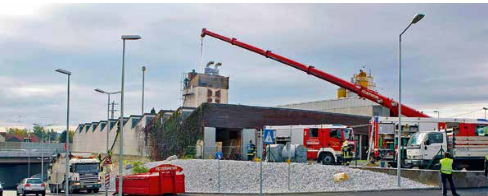
Die Einsatzstelle: Ein mit Sägespäne gefüllter Silo einer Tischlerei
