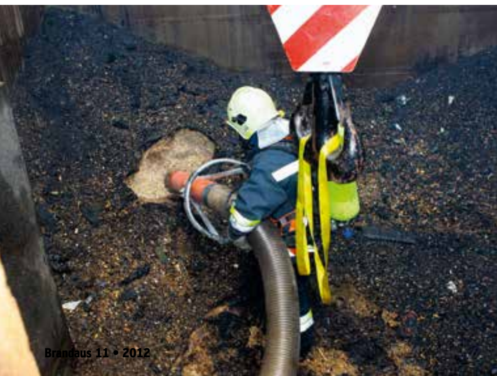
Bildtext unten: Absaugen der im Silo gelagerten Sägespäne. Die Sicherung erfolgte mittels Kranfahrzeug
