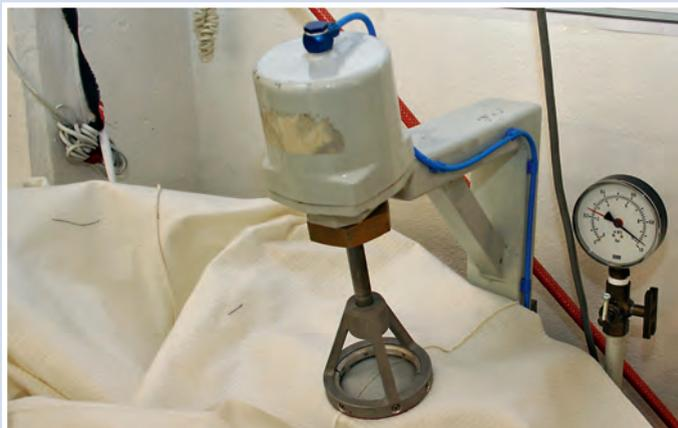
**7.** ...was bei der anschließenden Druckprobe mit ca. 1 bar Wasserdruck kontrolliert wird.
