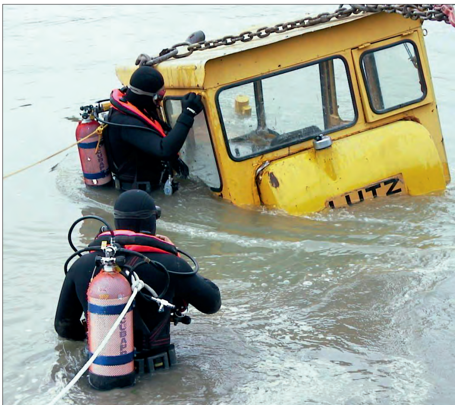
Der Tauchdienst verfügt über Ausrüstung für Arbeiten am, im und unter Wasser
