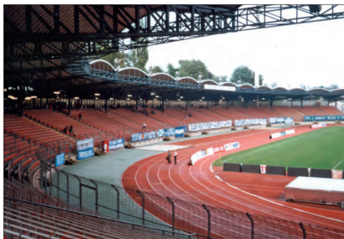
Das Linzer Gugl-Stadion wird zurzeit generalsaniert
