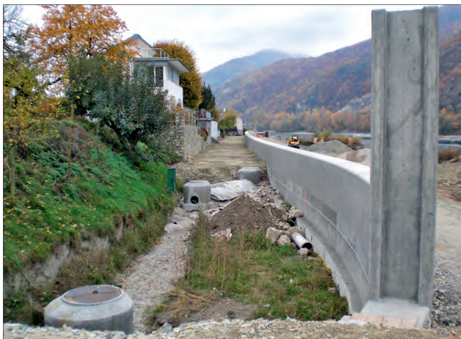
Verteidigungsweg zwischen Hochwasserschutzmauer und Wohnhäusern bzw. Einfriedungen
