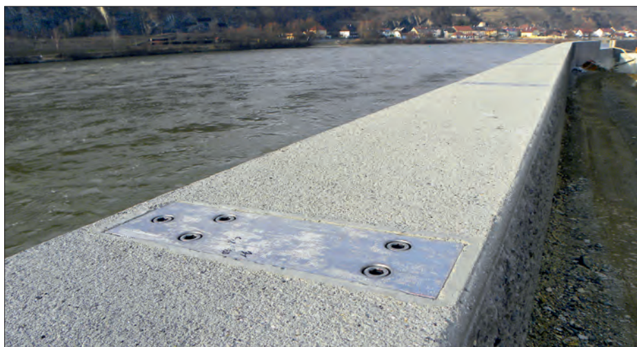
Anschlussplatte für die Steher der mobilen Hochwasserschutzwand
