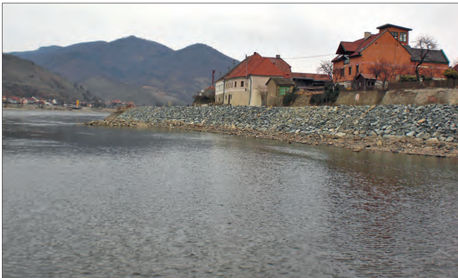
Studie über die Wirtschaftlichkeit: Wie man hier sehr gut sieht, liegt ein Ortsteil von Oberarnsdorf sehr exponiert direkt neben der Donau. Dieses Foto entstand beim niedrigsten Wasserstand 2012. Für den Wasserstand beim Hochwasser 2002 muss man hier zehn Meter hinzufügen
