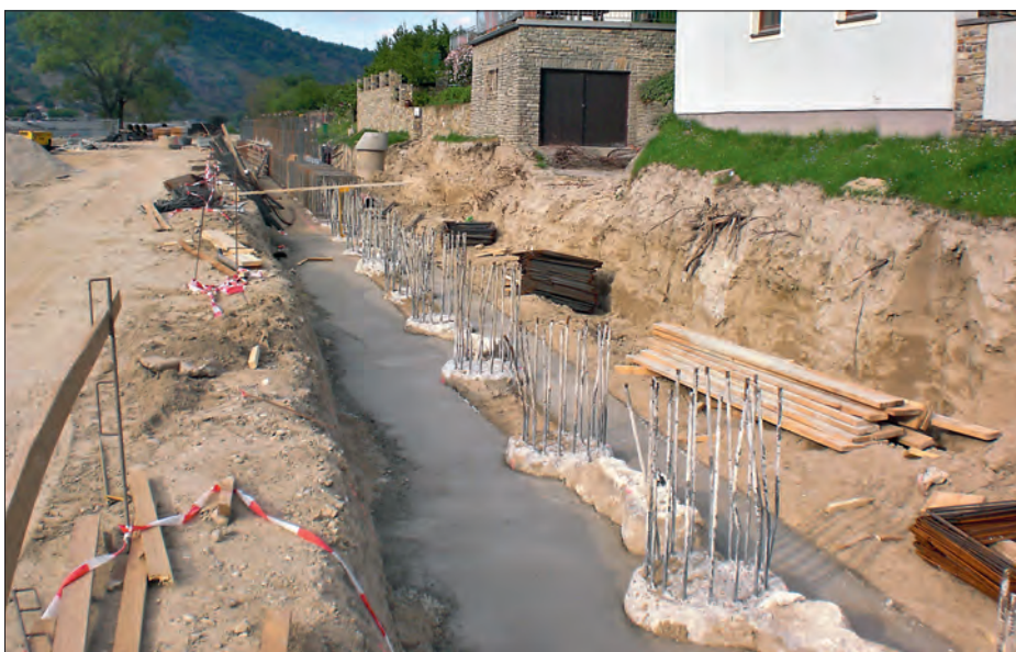
Fundamentierung einer mobilen Hochwasserschutzanlage – Bohrpfähle plus Dichtwand
