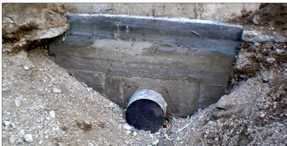
Noch nicht fertig gestellter Durchlass zur Löschwasserentnahme im Brandfall während eines Hochwassers
