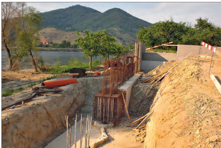
Wie voriges Bild nur im späteren Bauzustand - im Hintergrund sieht man bereits die Anschlussmauer
