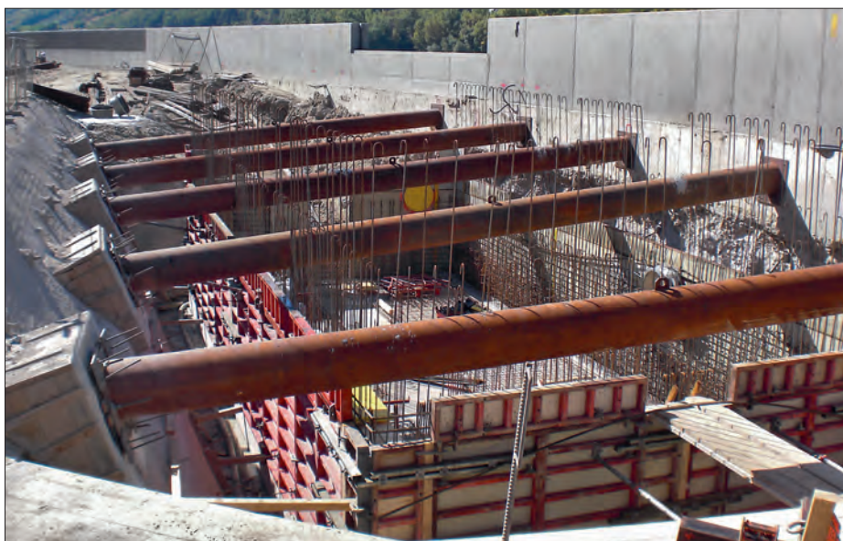
Fundamentierung des Pumpwerks (Ableitung des aus der Drainage zugeflossenen Wassers)
