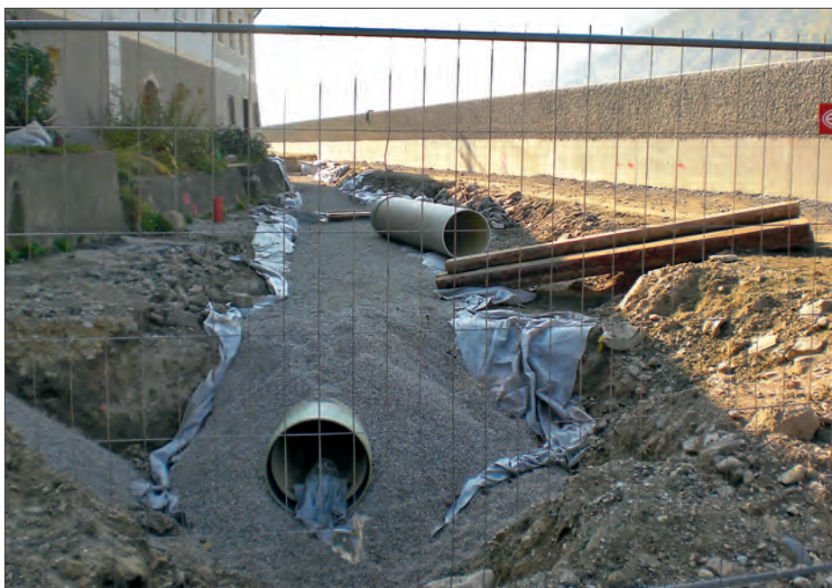
Drainagerohre hinter dem Hochwasserschutz
