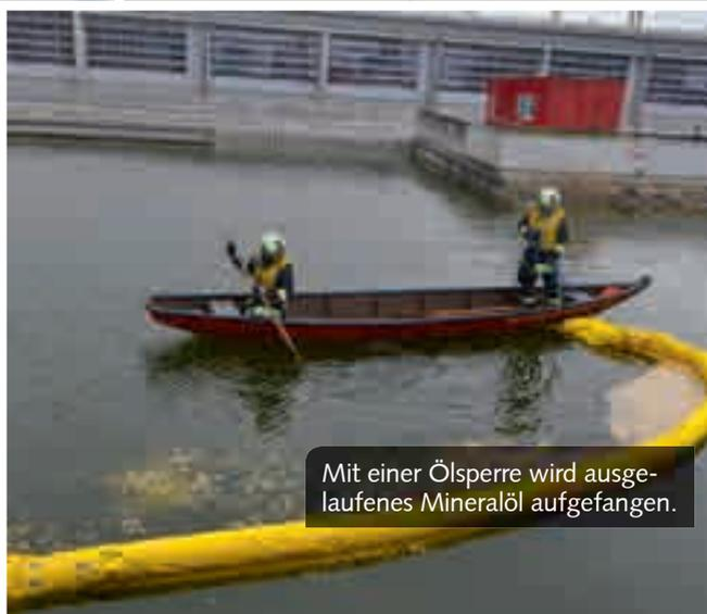
Mit einer Ölsperre wird ausge-laufenes Mineralöl aufgefangen.
