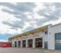
FF Emmersdorf: Alle Anforderungen unter einem Dach
