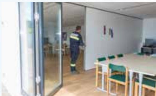
Schulungs- und Jugendraum werden von verschiebbaren Wandelementen getrennt. So werden bei Bedarf aus zwei Räumen ein großer Saal.
