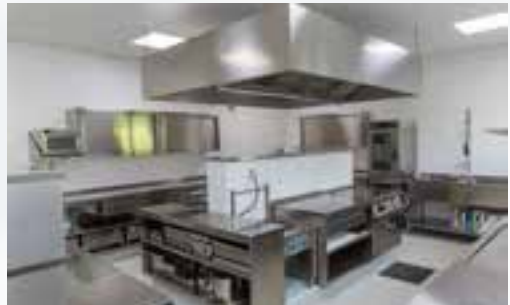
Im KHD-Einsatz können mit dieser Küche mehrere hundert Feuerwehrmitglieder sowie die Bevölkerung versorgt werden.
