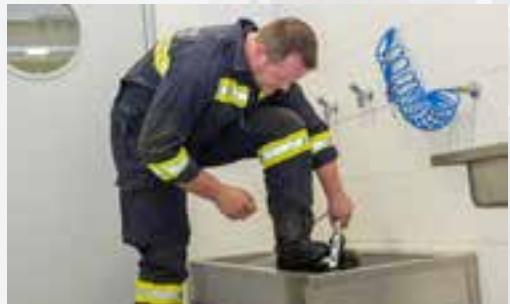
Die Schleuse zwischen Mannschaftstrakt und Fahrzeughalle wurde mit einer Stiefelwascheinrichtung versehen.
