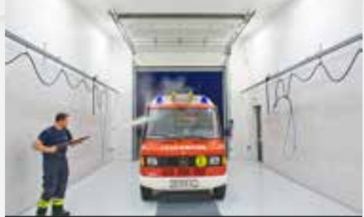
Die Waschbox ist mit einer Unterbodenwaschvorrichtung ausgestattet. Zusätzlich steht der Waschplatz auch der Gemeinde zur Verfügung.
