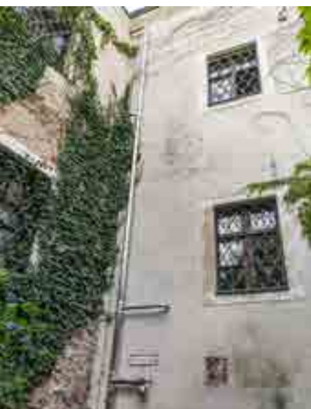
Platzmangel für Feuerwehr-Einsatzfahrzeuge: Im Ortskern von Dürnstein beugt man mit einem Steigleitungssystem vor.
