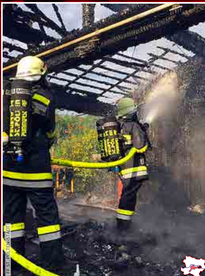
St. Pölten: In einer Kleingartensiedlung geriet eine Hütte in Brand. Mehrere Atemschutztrupps bekämpften den Brand, während die direkt angrenzenden Bauwerke vor dem Feuer geschützt wurden. Die abgebrannte Hütte wurde bei der Suche nach Glutnestern zur Gänze ausgeräumt.
