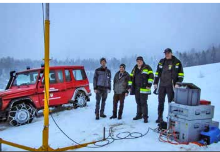
Digitalfunk: Aufbau einer mobilen Sendeanlage, um lokale Ausfälle, wie beispielsweise beim großen „Blackout“ in Slowenien, zu überbrücken.
