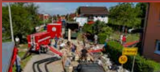
Flutkatastrophe Bosnien 2014: Abspumparbeiten mit Großpumpen SPA.
