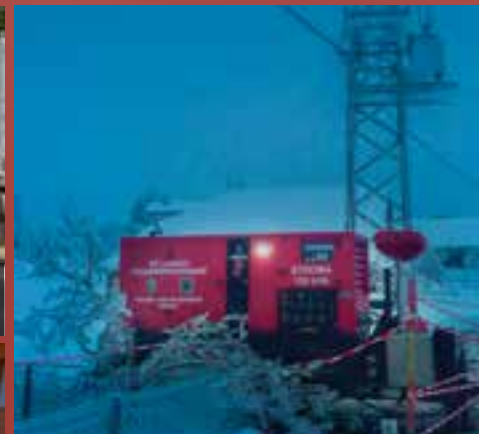
Eiskatastrophe Slowenien 2014: Stromversorgung von Ortsteilen sowie Krankenhäusern.
