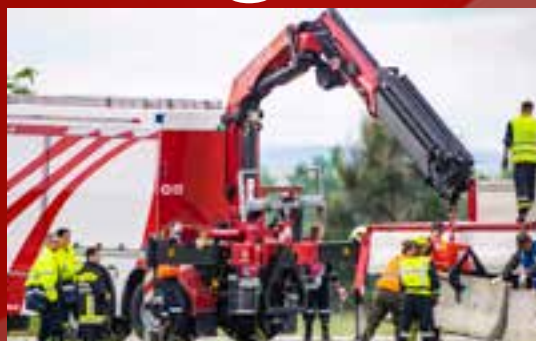
Donauhochwasser 2013: Dammerrichtung auf der Schnellstraße S5 Höhe Kraftwerk Theiß.
