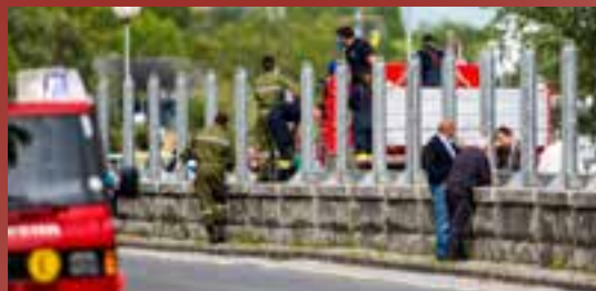
Donauhochwasser 2013: Aufbau zahlreicher Hochwasserschutzdämme, wie hier am Beispiel Stein.
