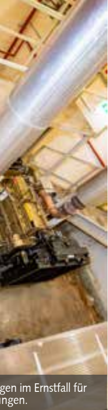
140 Rauchabzugslüfter sorgen im Brandfall für reine Atemluft. Die Funktionsprüfung wird monatlich durch Mitglieder der BTF durchgeführt.
