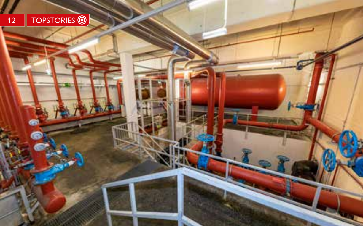
Die Sprinkleranlage wird aus mehreren Becken gespeist, die insgesamt 2.300 Kubikmeter Wasser fassen.
