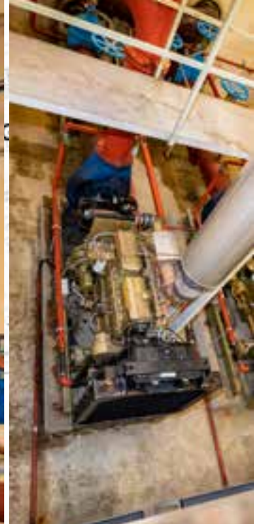
Leistungsstarke Diesellaggregate sorgen für ausreichend Druck in den Löscheinrichtungen.
