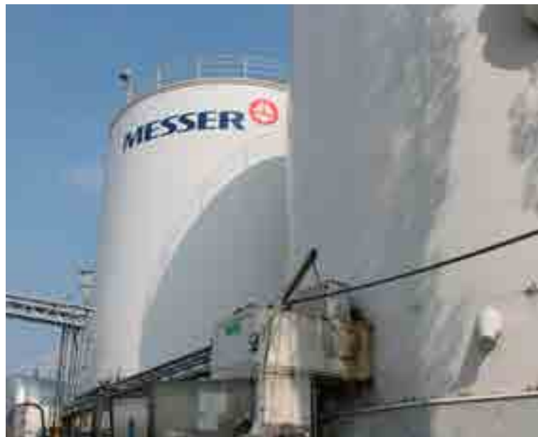
In zwei Tanks zu je 500.000 Litern wird Stickstoff vorrätig gehalten.
