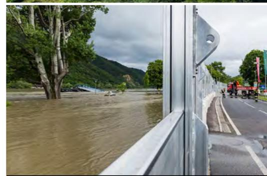
Eine mobile Hochwasserschutzanlage wird in der Wachau für Hochwasser im Jahr 2013 aufgebaut.
