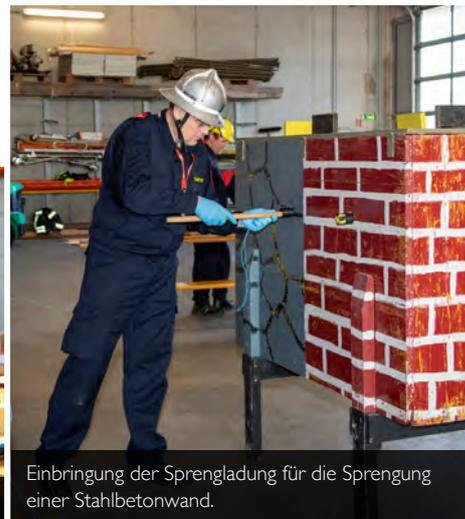
Einbringung der Sprengladung für die Sprengung einer Stahlbetonwand.
