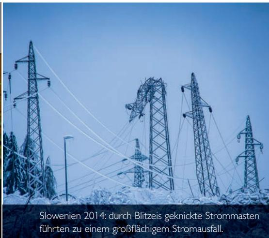
Slowenien 2014: durch Blitzeis geknickte Strommasten führten zu einem großflächigem Stromausfall.
