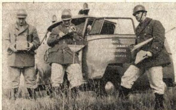
Praktische Ausbildung des Strahlenspürtrupps im Gelände, bestehend aus drei Mann: Kommandant (gleichzeitig Funker), Spürer und Markierer (gleichzeitig Fahrer). Im Vordergrund: Markiertafel.
