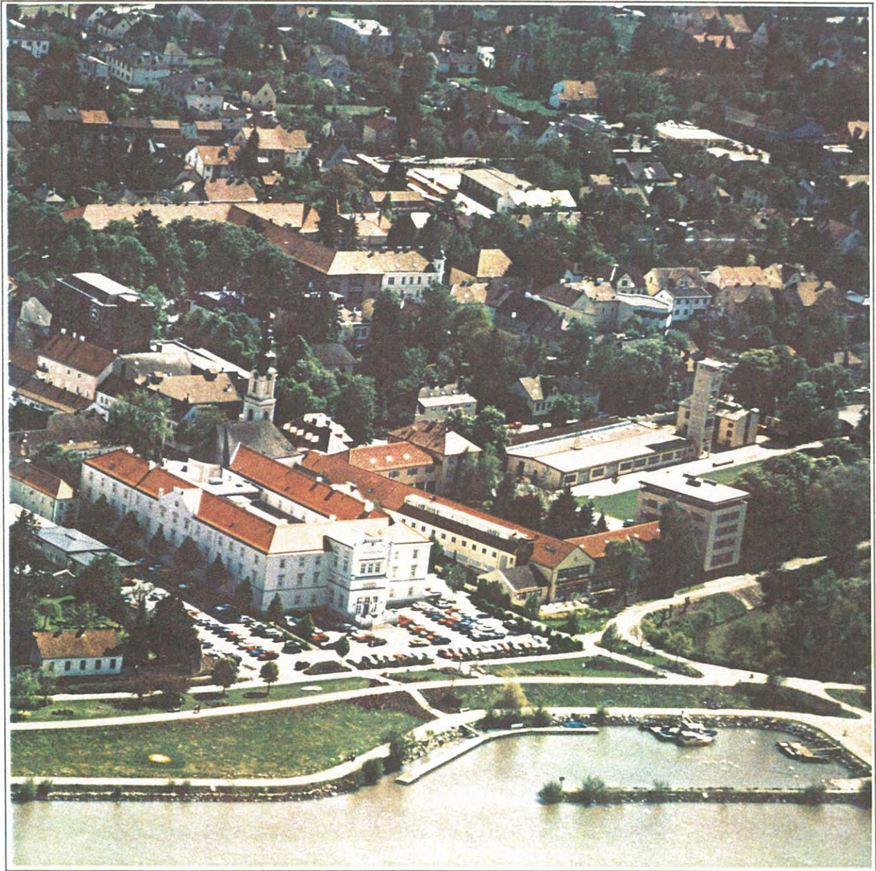
Das NÖ Feuerwehrzentrum in Tulln
