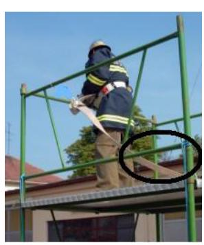
Befestigung der Löscheitung mit dem Schlauchhalter am Gerüst im markierten unteren Bereich, links oder. rechts der Leiter.
