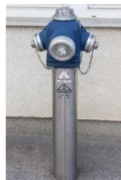
Armatur zur Entnahme von Wasser aus einem Wasserversorgungsnetz, dient zur Löschwasserversorgung
